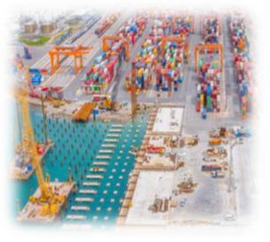
İnşaat & Kazık Boruları
